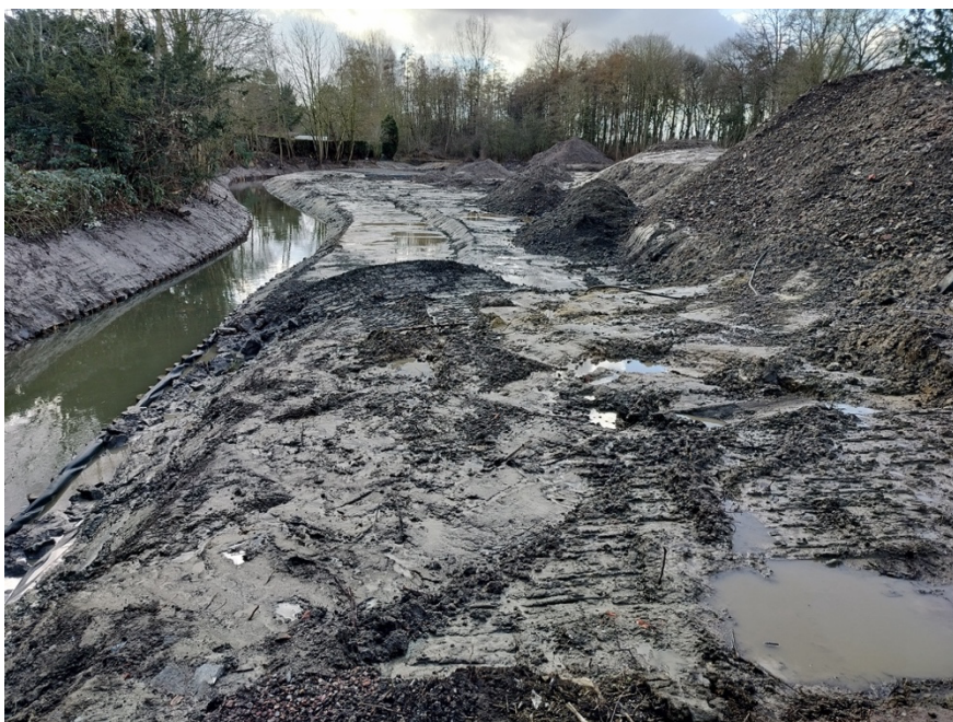
Op het voormalig stort bij de Poddegemhoeven hertselt de VLM de winterbedding van de Maalbeek zodat de beek weer ruimte krijgt.
